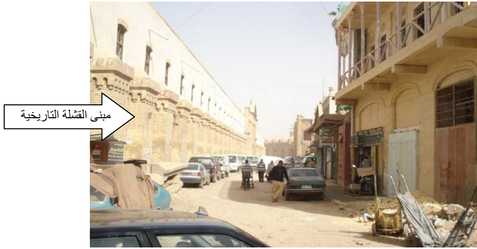
الشكل 8-7/2: انسجام المواد واللون والملمس في تطوير شارع المتنبي مع المواد المستعملة في مبنى القشلة التاريخية. المرجع: [فريق الاعداد]
