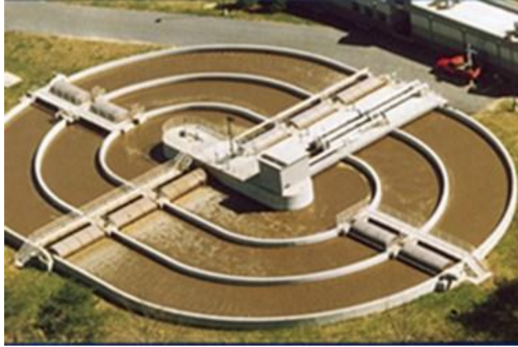
الشكل (4-2/4): نموذج قناة الأكسدة المطولة بنظام أوربال
