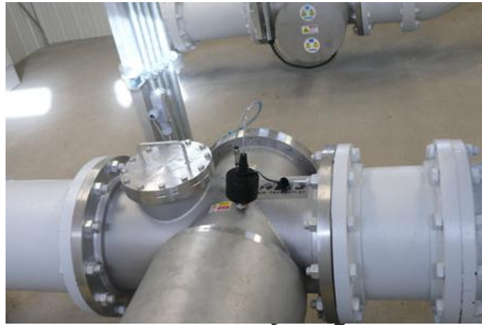
شكل 4-7/3: نظام القناة المغلقة وتكون فيها مصابيح أشعة UV للتعقيم عمودية على الجريان
